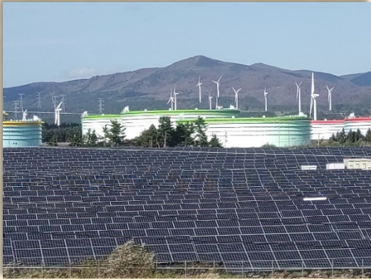
ソーラーパネルと石油タンク、風力発電の風車
